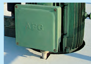
Ausschneiden vor Ort mit gewöhnlicher Stichsäge
